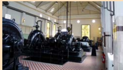
Die alte Pumpenhalle.
